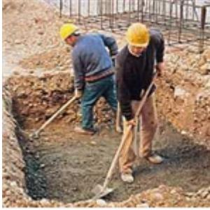
Trattasi della esecuzione di piccoli scavi a sezione obbligata eseguiti manualmente mediante l'utilizzo di pala e piccone.
